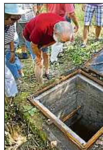
Der Schacht beim „grünen Baum“ geht tief unter die Erde.
