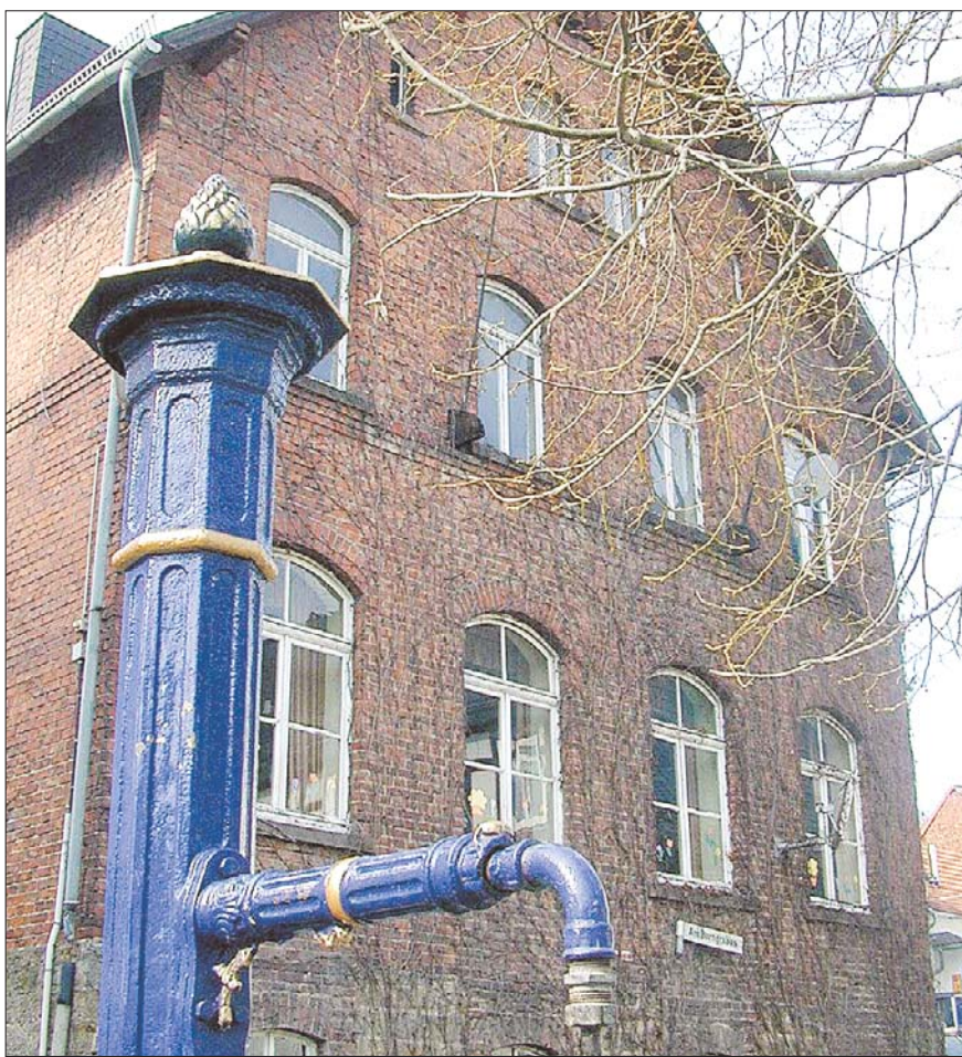
Das alte Schulgebäude in Frohnhausen soll auf jeden Fall saniert werden, unabhängig davon, ob eine Mehrzweckhalle gebaut wird oder nicht. Die Entscheidung über den neuen Projekt-Katalog fällt am Donnerstagabend. Foto: Hartmut Berge
