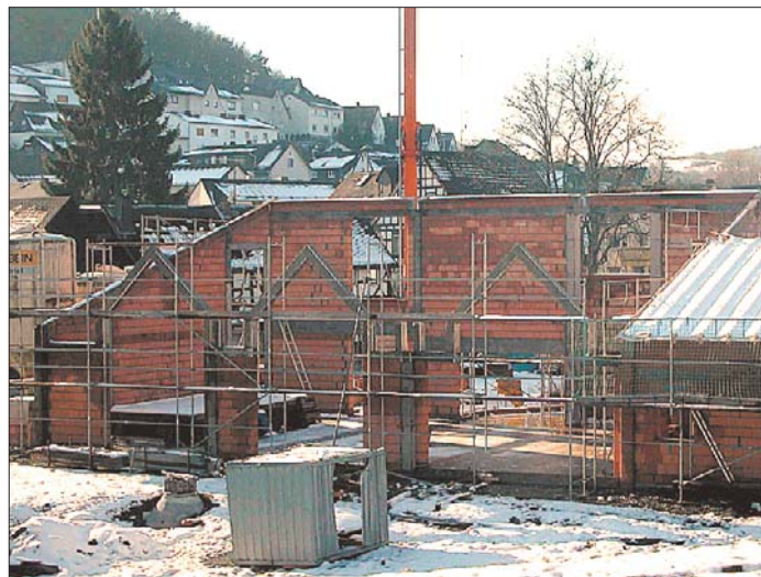
Im Januar vergangenen Jahres waren die Arbeiten am Rohbau des Dorfzentrums fast abgeschlossen.
