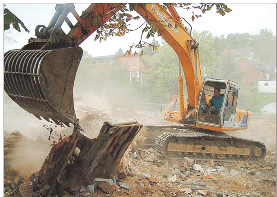
Den Plänen zum Umbau der Hofreite bereitete der Abrissbagger ein jähes Ende: Ehrenamtliche Helfer machten das Baudenkmal im Oktober 2003 dem Erdboden gleich.
