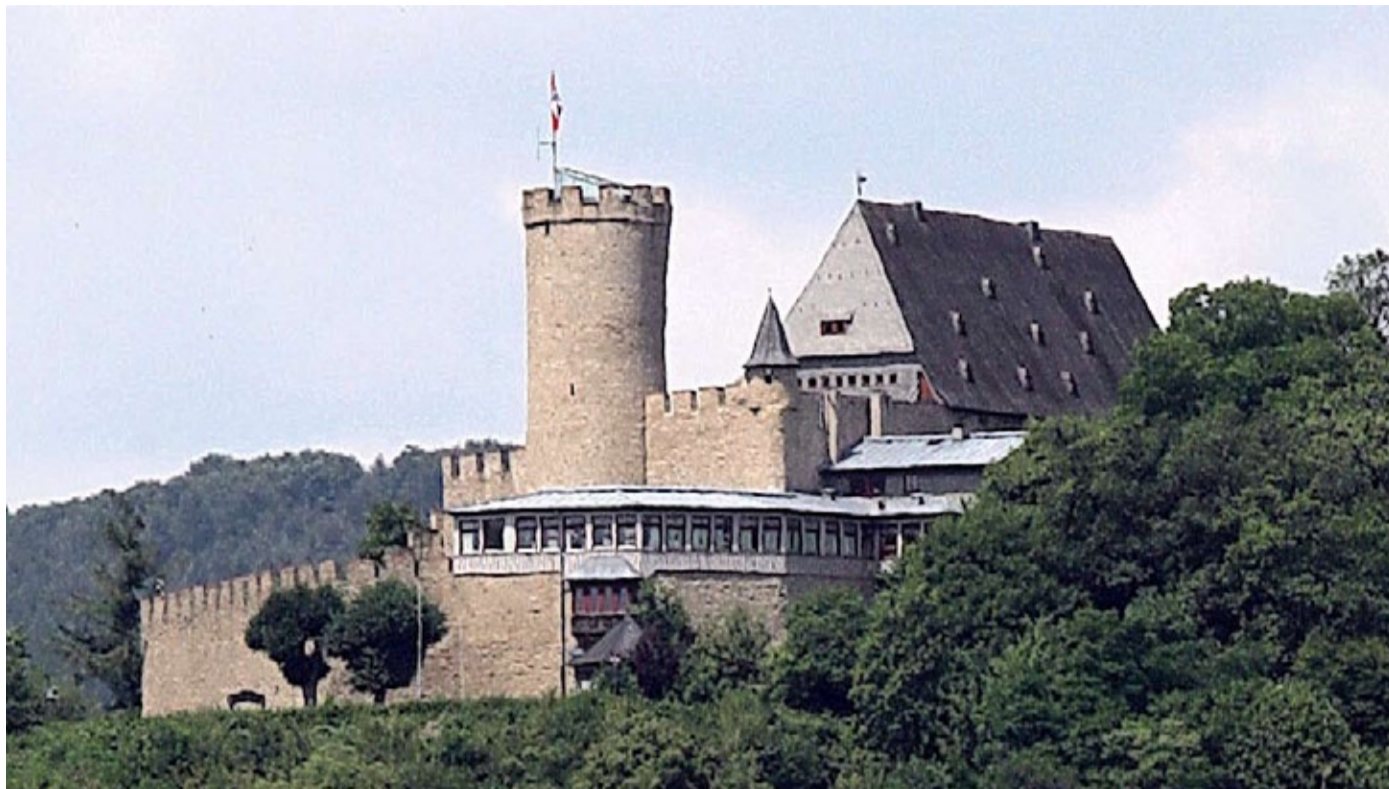
Für das Biedenkopfer Schloss werden Umbauarbeiten geplant.
