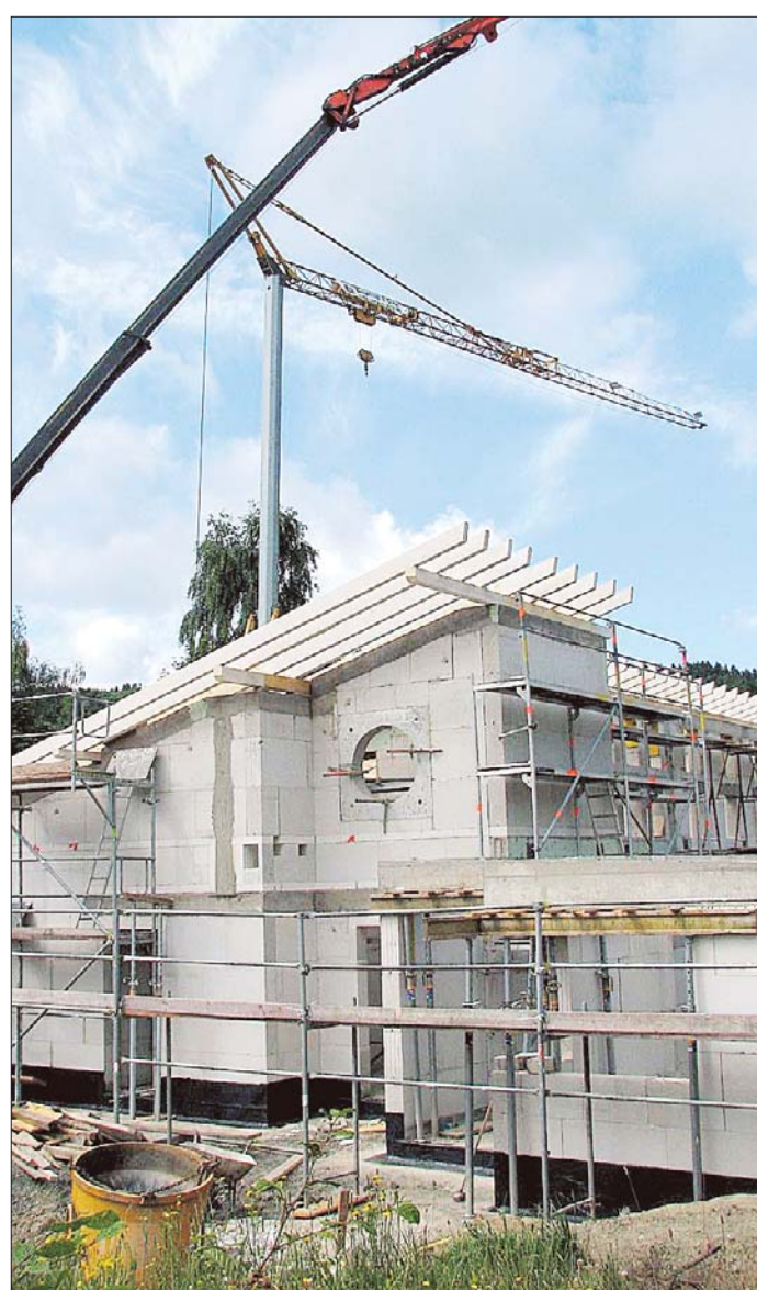
Zurzeit erhält der Kindergarten-Rohbau im Bad Endbacher Wiesengrund sein Dach. Bis zum Jahresende sollen alle Arbeiten an dem Gebäude abgeschlossen sein. Foto: Carina Becker
