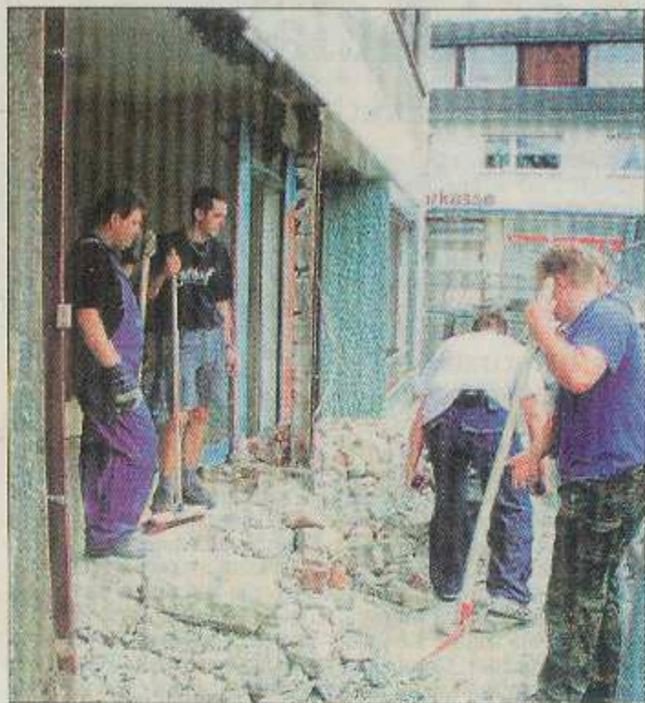
Helfer der Hartenroder Feuerwehr haben im vergangenen Jahr damit begonnen, ihre Räumlichkeiten im und am Dorfgemeinschaftshaus zu erweitern. Das Gebäude soll zu einem Haus der Vereine umfunktioniert werden. (Archivfoto: Röhi)
