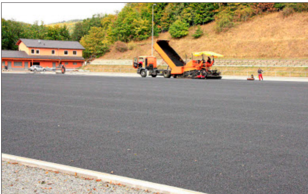
Die Grundlage für den neuen Kunstrasenplatz in Hartenrod ist fertig.
